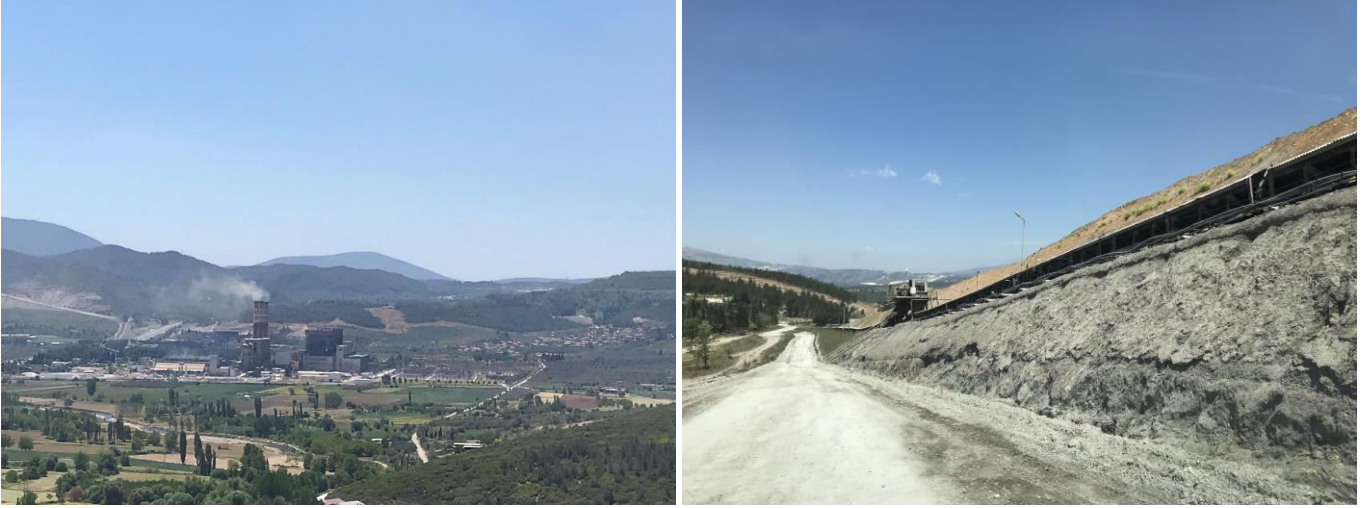
Şekil 13: Aktif olarak çalışmaya devam eden Yatağan termik santrali (solda) ve soğutma kuleleri (sağda)
