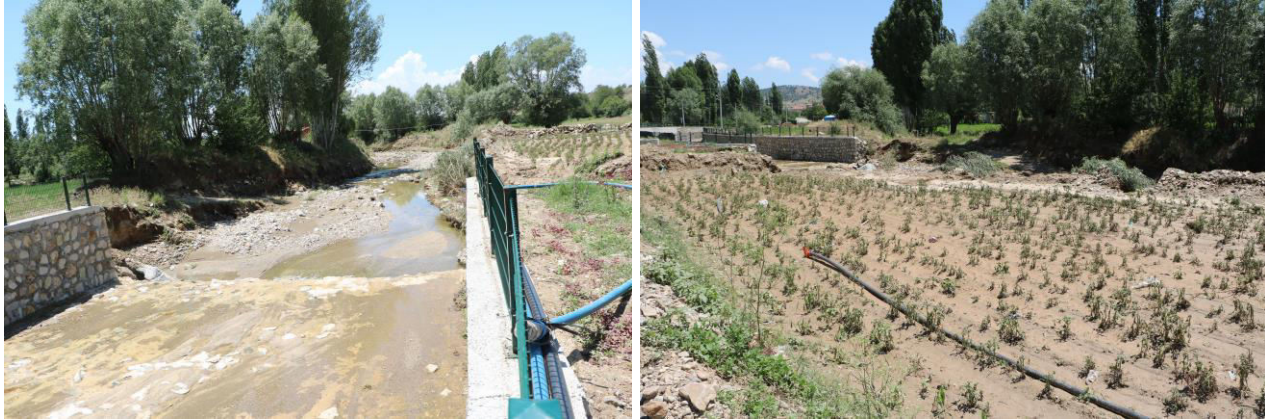
Şekil 21. Taşkın, Ayazini Deresi üzerinde taşkın koruma duvarının olmadığı kesimlerde olmuştur. Suyun ve taşkın materyalinin çevredeki tarım arazileri üzerine yayılması sonucu tarım ürünlerinde büyük hasarlar meydana gelmiştir.
