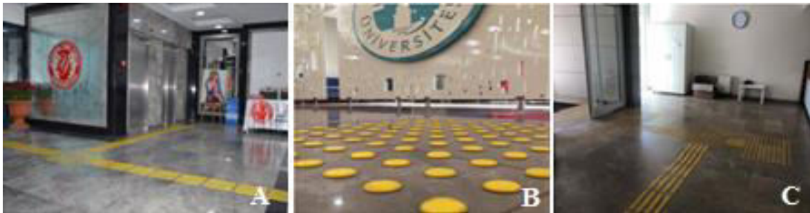
Fotoğraf 19. Duyumsanabilir Yüzey Uygulamaları, A. Yeni Yüzyıl Üniversitesi (Google Görşeller 19A) B. Üsküdar Üniversitesi (Google Görşeller 19B), C. Boğaziçi Üniversitesi (Google Görşeller 19C)
