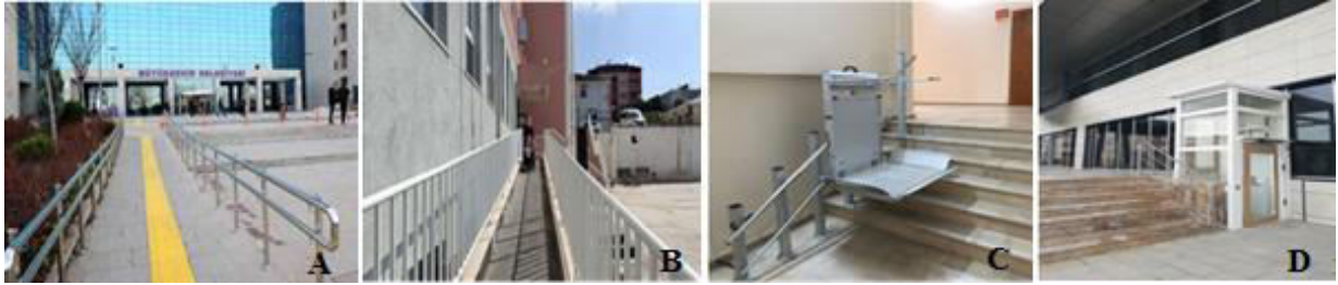
Fotograf 4. Yapı Giriş Örneği, A. Ankara Büyükşehir Belediyesi (Google Görseller 4A), B. Kandıra Anadolu Lisesi (Google Görseller 4B), C. Zonguldak Belediyesi Platform Tipi Engelli Asansörü (Google Görseller 4C), D. Erzincan Binali Yıldırım Üniversitesi Rektörlük Engelli Asansörü (Yücel, M. Arşivi, 2021)
