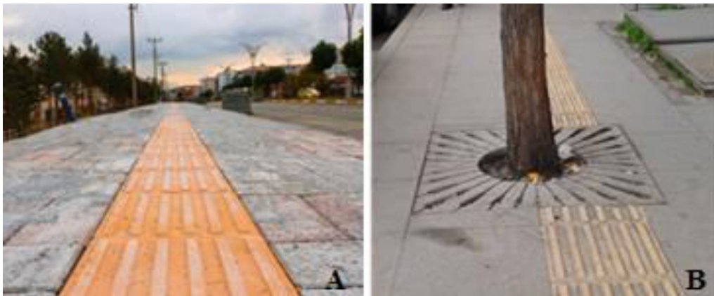
Fotoğraf 1.A. Olumlu Kaldırım Örneği [Yeterli kaldırım genişliği, nitelikli yüzey kullanımı ve engel oluşturmayan peyzaj uygulaması (Google Görseller 1A)], B. Olumsuz rampa örneği [Yetersiz kaldırım genişliği, hatalı duyumsanabilir yüzey ve niteliksiz peyzaj uygulaması (Google Görseller 1B)]
