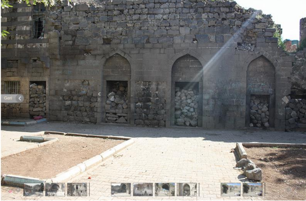
Foto 7: Kuzey Cephesi Kaynak: DKTM, 2012
