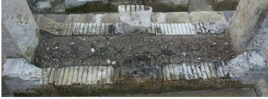
Foto. 39: Salihyye Bahçeleri Tekke Yapısı, Mirac'a ait Mezarın Pehle Yüzünden Detay
