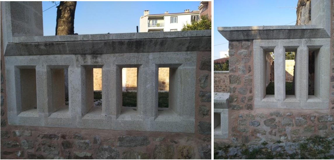
Şekil 20. Kâbûlî Mustafa Efendi Türbesi Uygulama Sonrası Dış Duvarları ve Pncereleri, 2019
