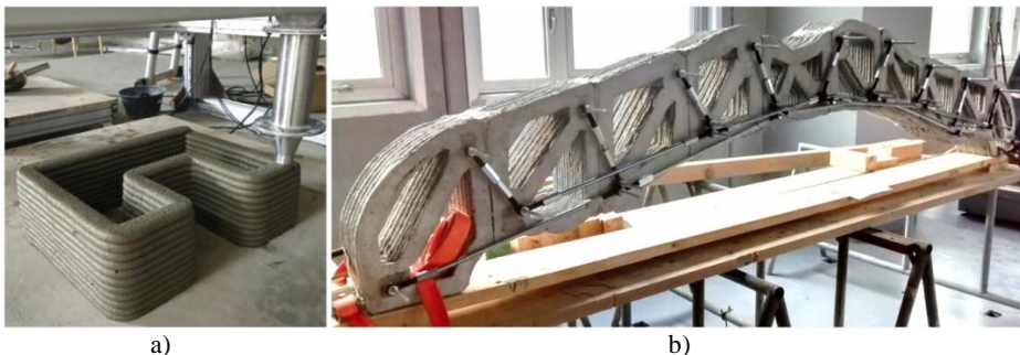
Şekil 3: (a) 3B yazıcı teknolojiyle yapı elemanlarının üretilmesi, (b) 3B yazıcı teknolojiyle üretilen beton kiriş
