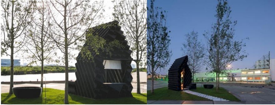
Şekil 9: 3B yazıcı teknolojiyle üretilen polipropilen malzemelerin ev yapımında kullanılması Kaynak: URL 2
