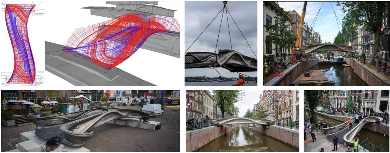
Şekil 6: Joris Laarman Lab ve Arup tarafından tasarlanan 3B yazıcı teknolojisinden yararlanılarak yapılan çelik köprü Kaynak: URL 1
