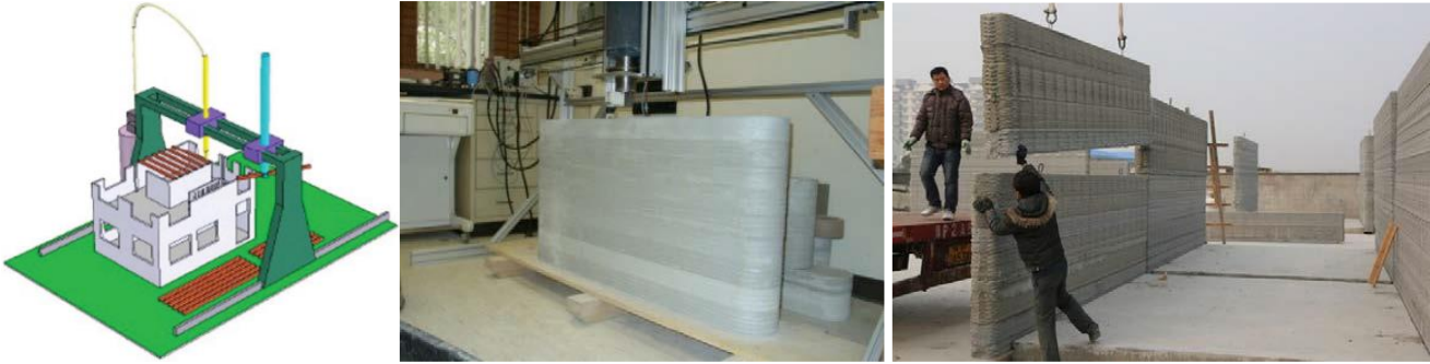
Şekil 1: FDM yöntemiyle üretilen duvarların yapı inşasında kullanılması
