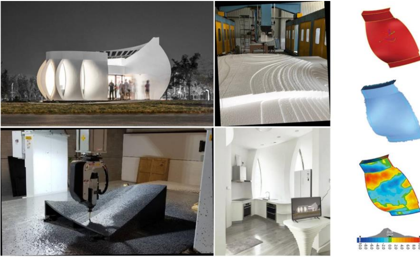
Şekil 16: Lotus evin 3B yazıcı teknolojisi kullanılarak yapılması
