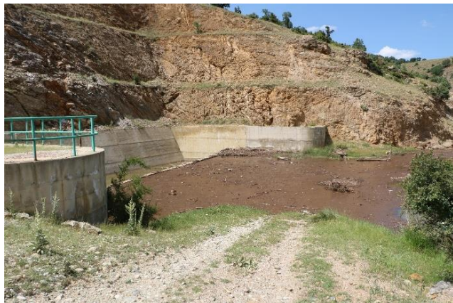
Şekil 20. Aşırı yağış sonrası Ayazini Barajı, sel sularının getirdiği balık ve çamur malzeme, ağaç parçaları ile kaplanmıştır.
