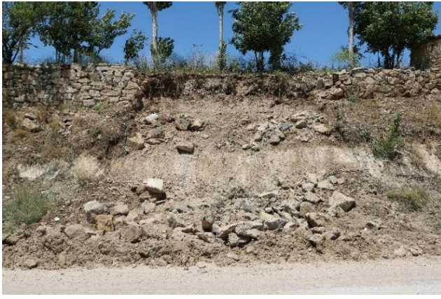
Şekil 19. Sel suları tarafından yıkılmış taş duvarlar.
