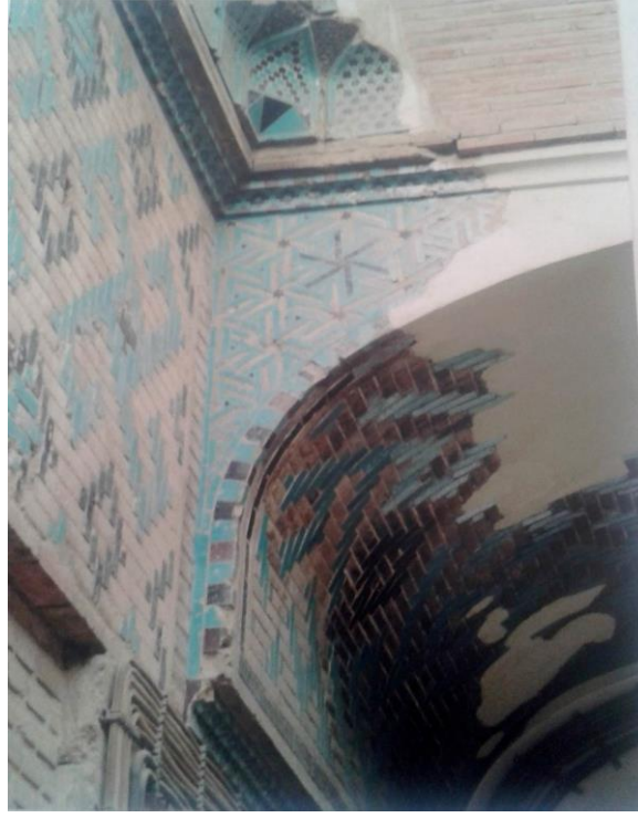
Resim 4: Tonzun avluya bakan köşe dolguları
