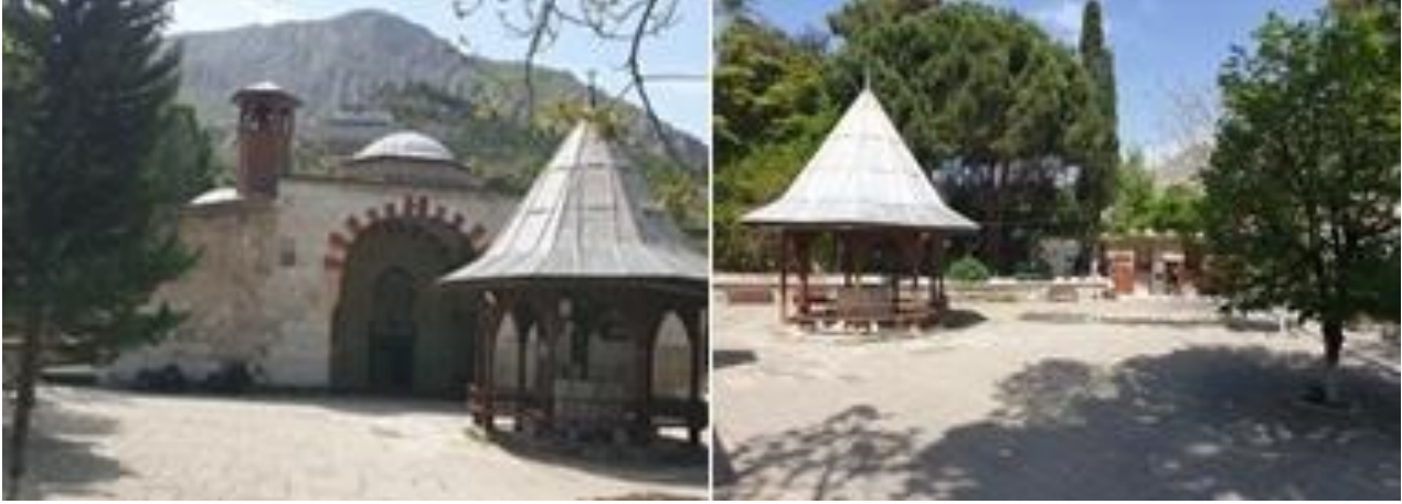
Fotoğraf 2. Yörgüç Paşa Cami ve Türbesi, Kuzey Cephe, Şadırvan ve Tuvalet (Dikmen ve Toruk Arşivi, 2019)
