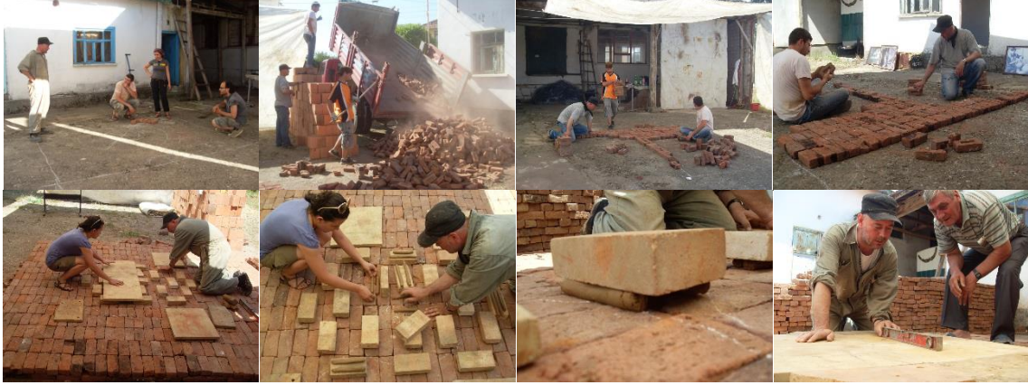
Şekil 10. Eski un değirmeni iç avlu, zemini hazırlanması ve teraziye alınması (Fotoğraflar Ergün Arda, 2012)
