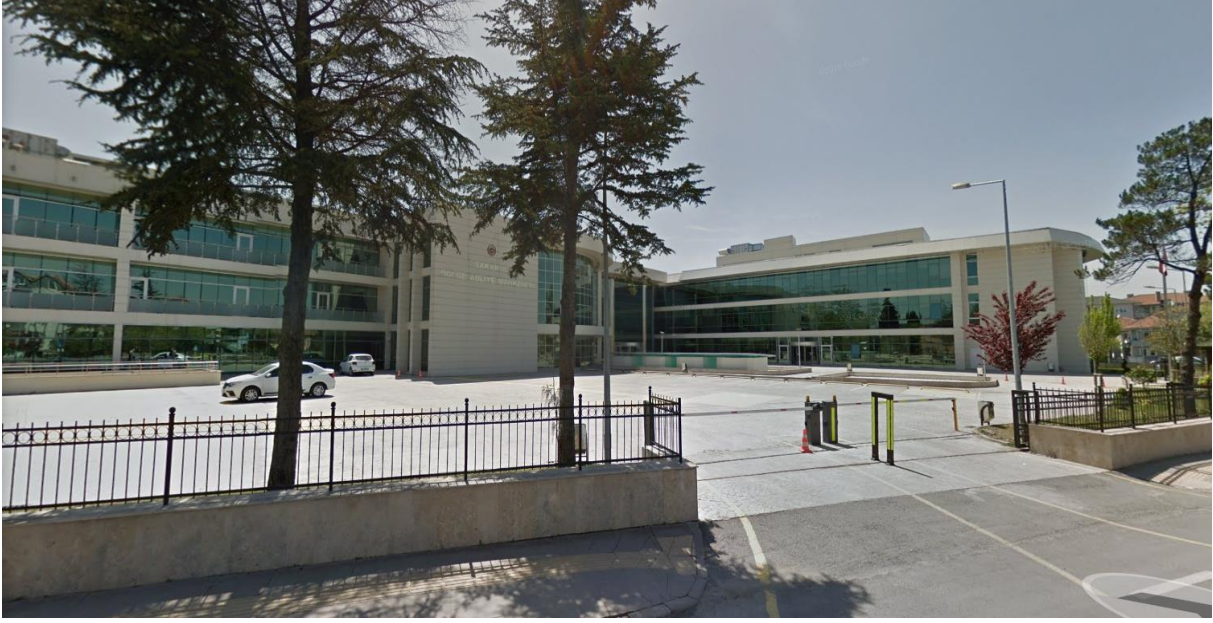
Şekil 6. Sakarya Bölge Adliye Hizmet Binası Yoldan Görünüş
