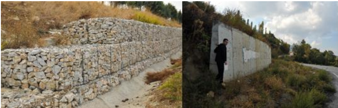
Fotoğraf 7: Babadağ-Sarayköy yolunda çelik tel destekli taş duvar ve beton istinat duvarları heyelana karşı tedbir olarak yapılmıştır.
