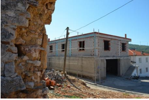
Şekil 35. Köyün kuzeyinde bir beton+tuğla yapı örneği
