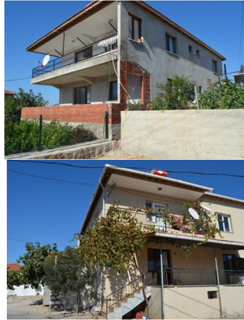
Şekil 22. Köyün merkezine yakın konumda bulunan iki katlı yapı örnekleri
