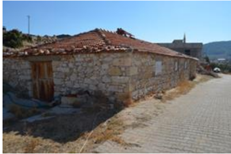
Şekil 48. Alaturka ve Marsilya tipi kiremit malzemeli iki farklı kırma çatı örneği
