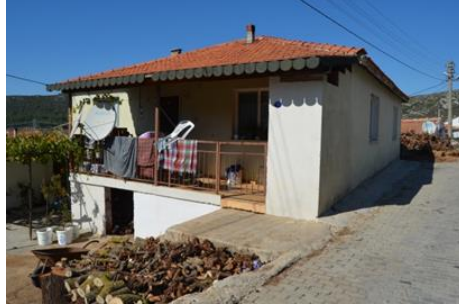
Şekil 48. Alaturka ve Marsilya tipi kiremit malzemeli iki farklı kırma çatı örneği
