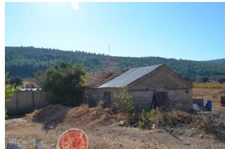
Şekil 49. Metal malzemeli iki farklı beşik çatı örneği
