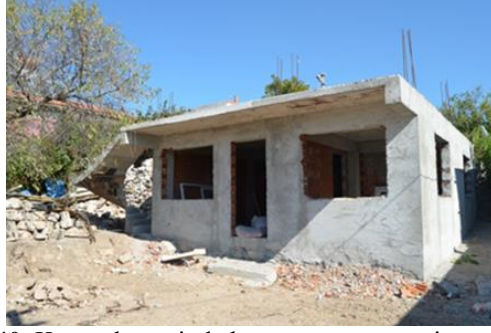
Şekil 40. Köyün kuzeyinde betonarme yapım sistemi örneği
