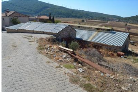
Şekil 49. Metal malzemeli iki farklı beşik çatı örneği
