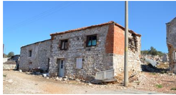
Şekil 39. Köyün kuzeyinde yığma taş+tuğla yapım sistemi örneği
