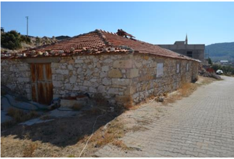
Şekil 38. Köyün merkezine yakın bir konumda yığma taş yapım sistemi örneği
