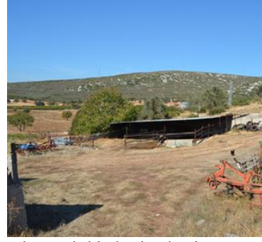
Şekil 36. Köyün batısında bir demir+alüminyum yapı örneği
