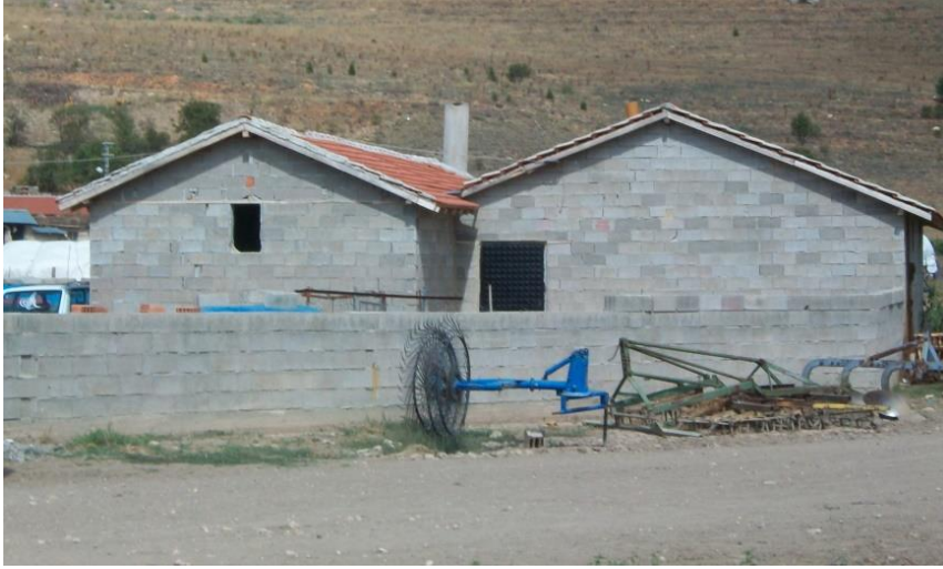
Fotoğraf 6. Burunkaya Köyü’nde Briketle Yapılmış Hayvan Barınağı. Geçmişte meskenlerin alt katı hayvan barınağı olarak kullanılırken, günümüzde bu eklentiler meskenin yanına ya da meskenden ayrı olarak inşa edilmektedir. Briket kullanılarak yapılan bu hayvan barınağı meskenden ayrı inşa edilmiştir.
