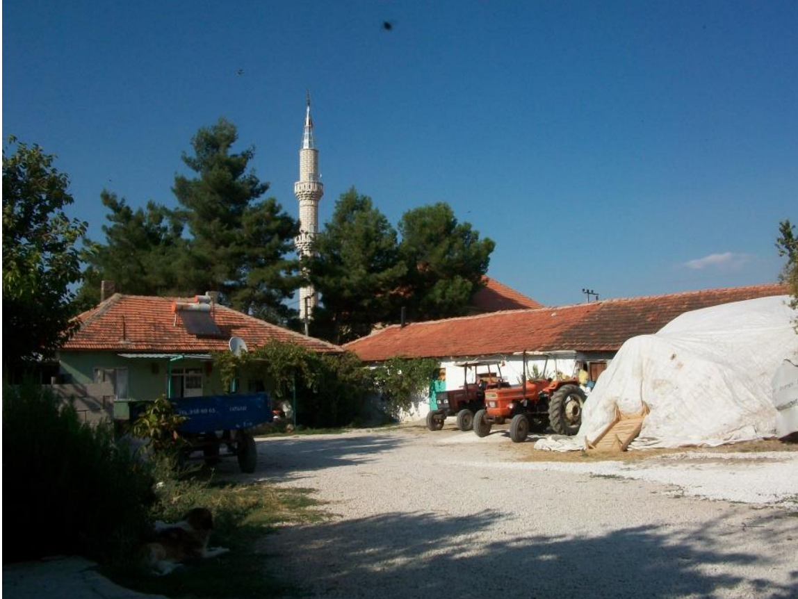
Fotoğraf 10. Akgün Köyü’nde Kırma Çatı (Mesken) ve Beşik Örtü (Ahır) Tarzında İnşa Edilen Çatı Tipleri. Meskenlerin çatıları genellikle kırma çatı tarzında inşa edilirken, ahır ve ağılların çatıları ise iki yana eğimli olan beşik örtü tarzında inşa edilmiştir.
