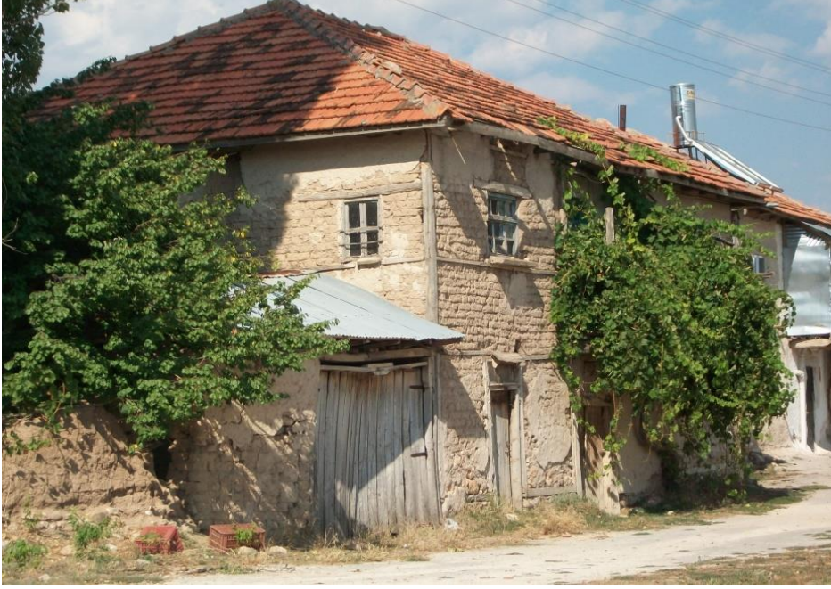
Fotoğraf 1. Dombay Köyü'nde Kerpiç Mesken Görünümü. Kerpicin ana yapı malzemesi olarak kullanıldığı bir kırsal mesken örneği. Havzadaki kerpiç meskenlerin çoğu günümüzde terk edilmiş durumdadır.
