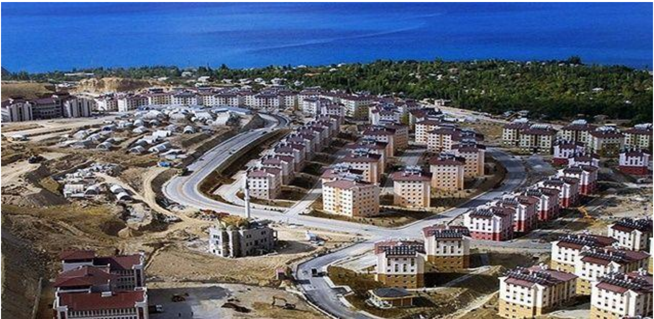
Foto 4: 2011 Van Depreminden sonra Edremit'te TOKİ tarafından yapılan deprem konutları.
