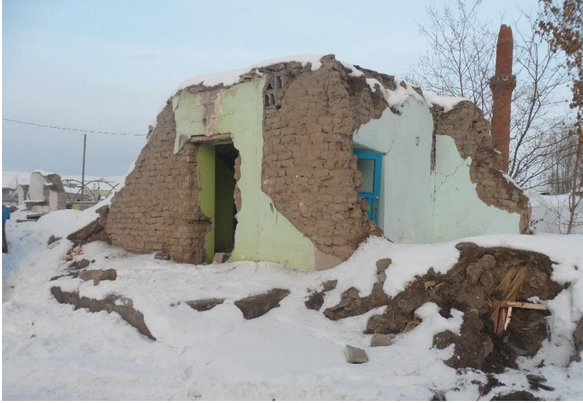
Foto 1. Depremde yıkılan bir kerpiç (toprak) ev.
