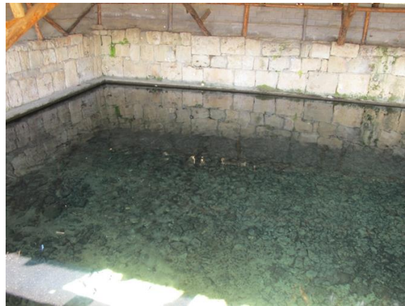
Fot.12: Havuzun iç kısmının görünümü
