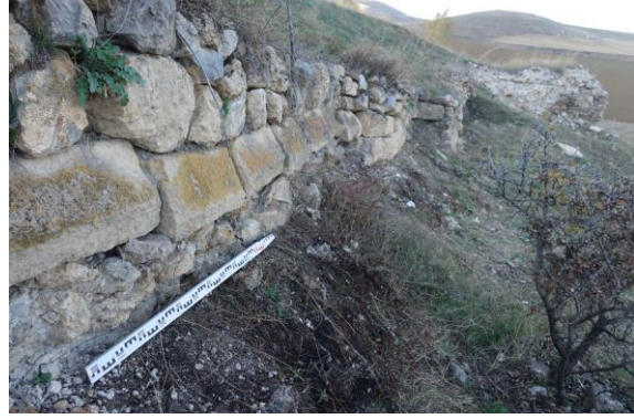
Fot. 7: Doğu sur duvarlarının genel görünümü
