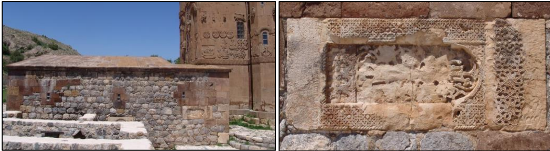
Foto. 9 - 10: Akdamar Manastırı Katogikos Thomas Jamatunu güney cephesi ve cephe yüzeyindeki devşirme haç işlemeli taş
