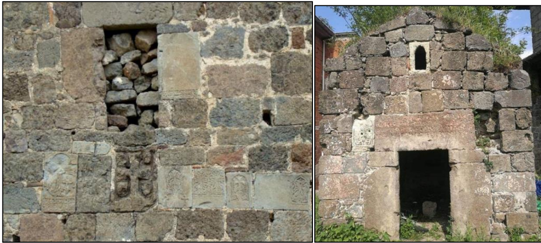
Foto. 25-26 : Trabzon - Kaymaklı Manastırı Kilisesi güney ve Şapel batı cephesindeki devşirme haç işlemeli taşlar
