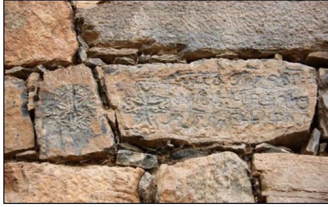
Foto. 17 : Van – Çatak Albıçak (Cunuk) Kilisesi güney cephe doğu köşesindeki devşirme haç işlemeli taş (Muhammet Taha Çohaz,2012)
