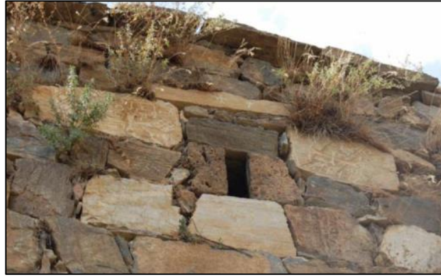
Foto. 18 : Van – Çatak Sak Kilisesi doğu cephesindeki devşirme haç işlemeli taşlar (Muhammet Taha Çohaz, 2012)
