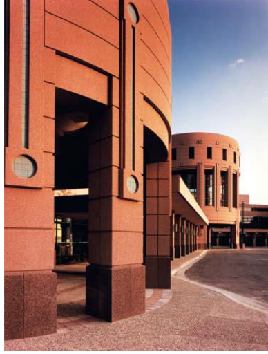
Şekil 4. Prekast beton malzemesiyle farklı cephe tasarımı yapılabilmesine örnek (URL 3)
