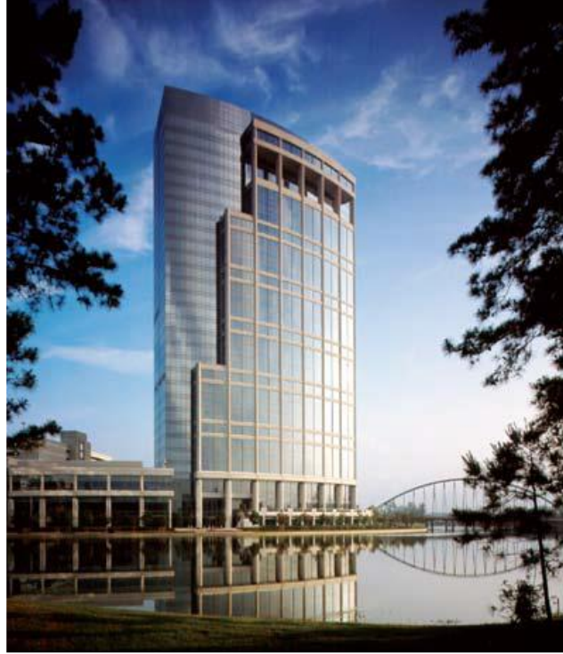
Şekil 9. Teksas'ta bulunan Anadarko kulesi cephe tasarımında farklı doku teknikleriyle oluşturulmuş prekast panellerle kaplanması (URL 2)
