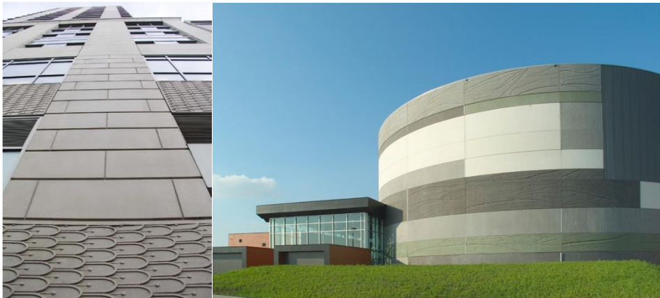
Şekil 3. Yapı cephe tasarımında prekast duvar panelleri ile çeşitli desen ve dokular oluşturulması (URL 1)
