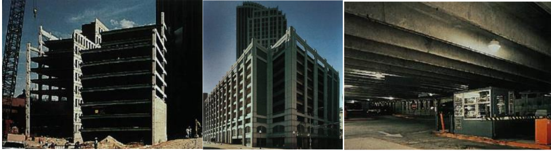
Şekil 23. Amerika'nın Kuzey Carolina şehrinde 10 katlı otopark yapısını prekast ön gerilmeli beton inşa edilmesi (Stewart, Hamvas ve Gleich, 2000)
