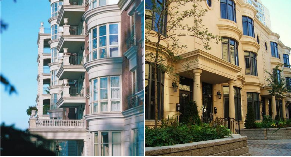
Şekil 1. Prekast beton panellerin yapılarda çeşitli biçim ve dokular oluşturabilmesine örnekler (URL 1)
