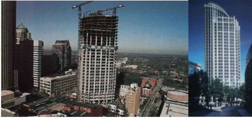
Şekil 22. Amerika'nın Kuzey Carolina şehrinde 30 katlı IJL Finans Merkezi tasarımında prekast beton malzemesi kaplanması (Stewart, Hamvas ve Gleich, 2000)
