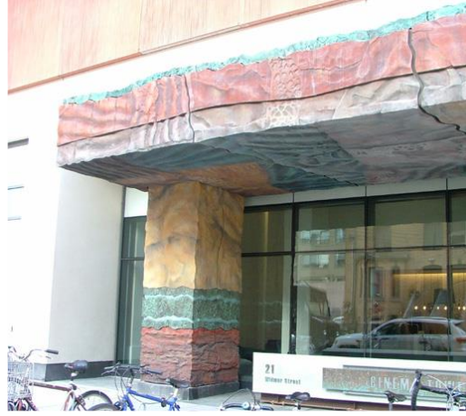
Şekil 5. Prekast betonun farklı renklerle yapılmış mimari tasarım örneği (URL 1)
