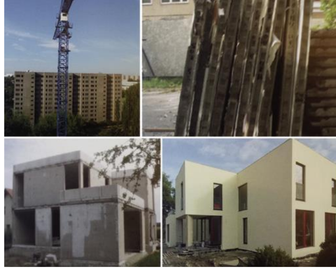
Şekil 25. Berlin yakınlardaki Mehrow'da yeni konut inşaatı için prekast beton plakaların ve panellerin yeniden kullanımı (Stacey, 2011)
