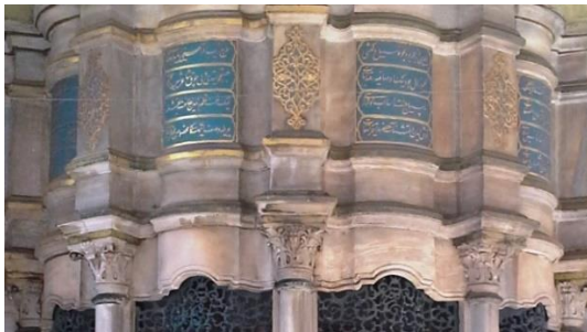
Foto. 15: Seyyid Hasan Paşa Sebili İçbükey Dışbükey Cephe Örneği.
