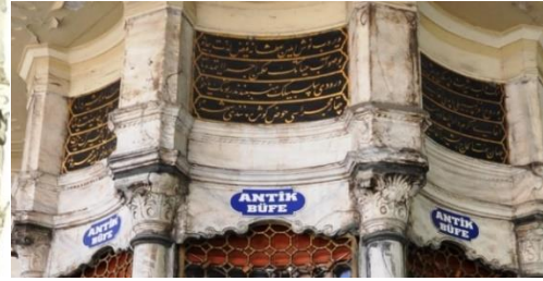
Foto. 14: Hacı Beşir Ağa Sebili İçbükey Cephe Örneği.
