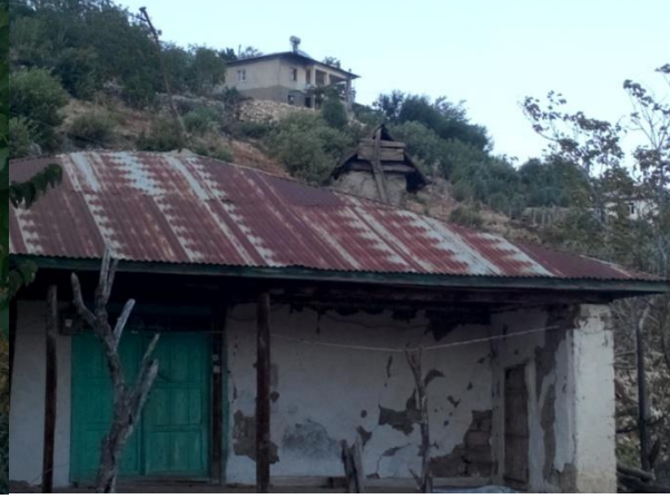
Resim.17.: Çinko çatılı ve arkada görülen betonarme ev (Saha çalışması sırasında tarafımızdan görüntülenmiştir).
