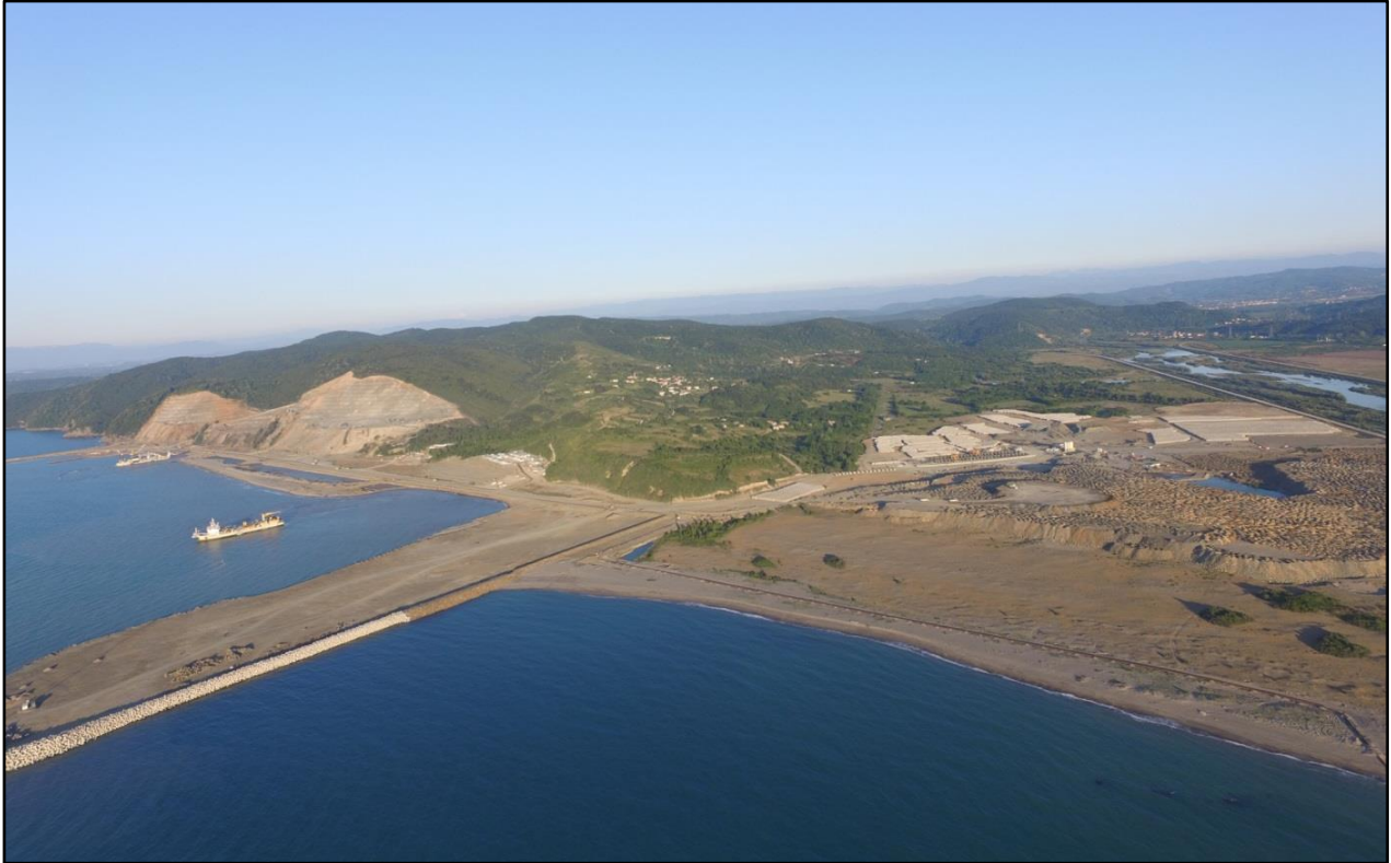
Fotoğraf 7. İnşaatına devam edilen Filyos Limanı'nın çalışma alanından bir görünüm.
