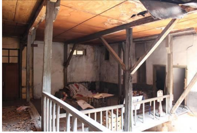
Fotoğraf 53. Birinci kat kuzey revak, doğu ve kuzeyi
