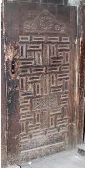
Fotoğraf 24. Güneyden ikinci odanın kapısı
