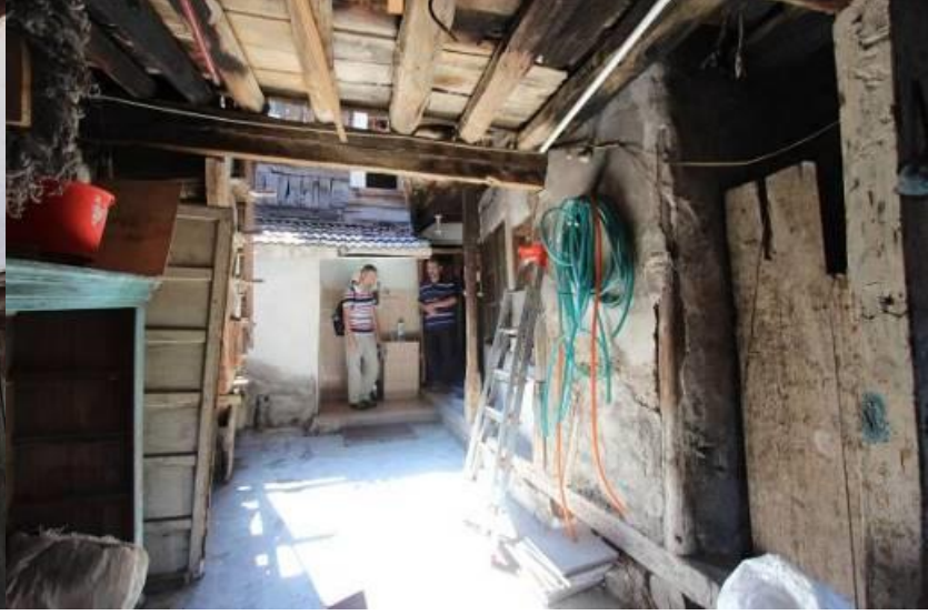
Fotoğraf 3. Avlu ve doğu cephe, kuzeyden güneye bakış
