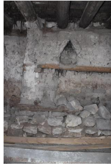
Fotoğraf 14: Ahır batı duvarındaki baca deliği.
