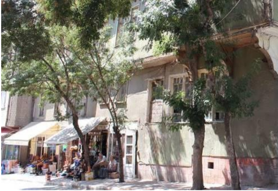
Fotoğraf 44. Doğu cephe zemin ve birinci kat (kuzeyden güneye bakış)
