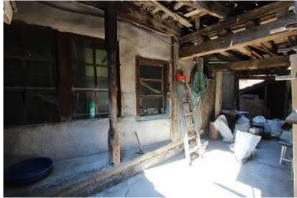
Fotoğraf 4. Zemin kat doğu cephe ve avlu, güney doğudan bakış.
