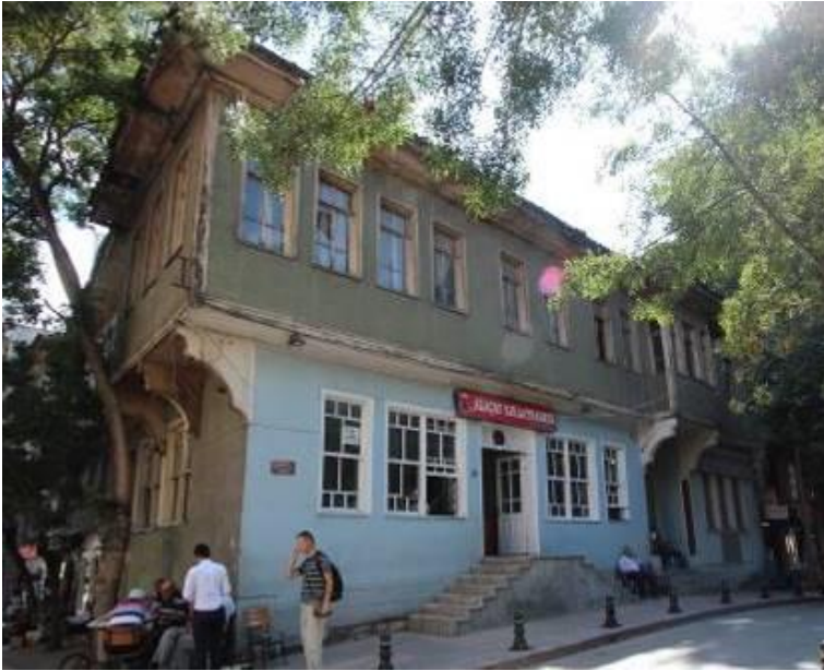
Fotoğraf 42. Kuzey cephe
