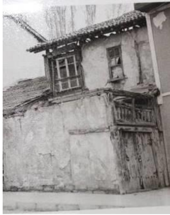
Fotoğraf 12. Birinci kat kuzey odanın kuzey cephesi 7 (İ. Hoşafçioğlu)
