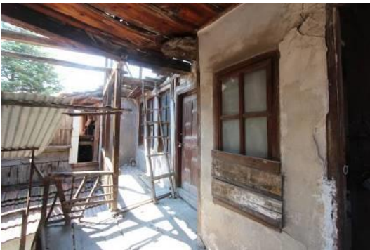
Fotoğraf 5. Birinci kat doğu cephe, kuzeyden güneye bakış
