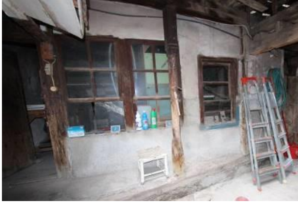
Fotoğraf 7. Doğu cephe zemin kat pencere düzeni
