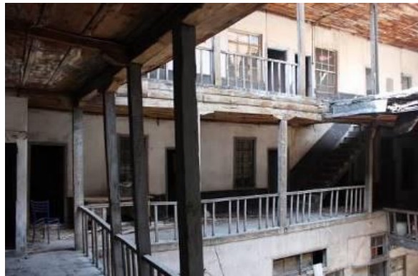
Fotoğraf 55. Birinci kat revak batı tarafı (güneyden bakış)
