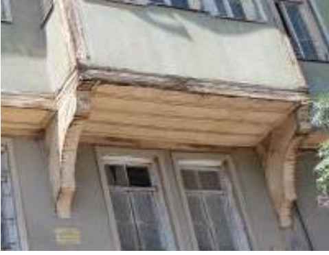
Fotoğraf 69. Dışta doğudaki çıkmanın konsolu
