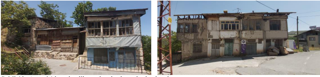
Şekil 10: Arapgir'de terk edilen geleneksel yapılardan bazıları
