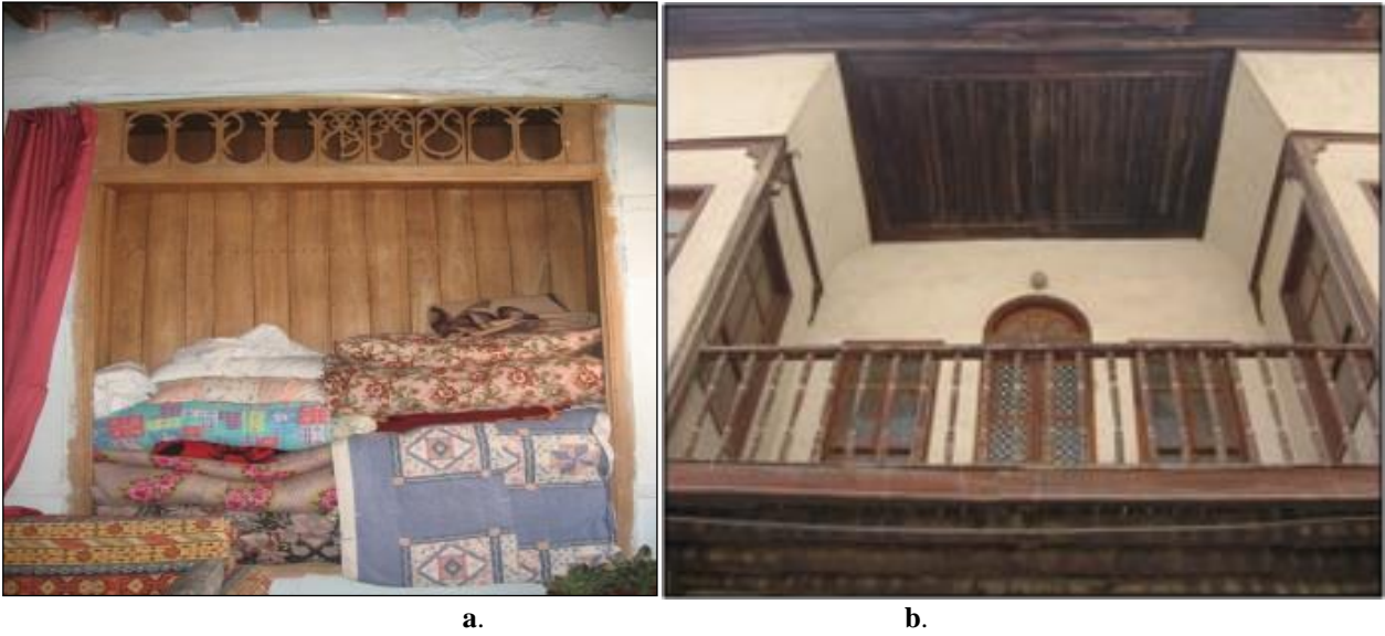
Şekil 3. Geleneksel Malatya evi a. ahşap yatak dolabı ile b. ahşap balkon korkuluk No:12 (Durgun,2006).
