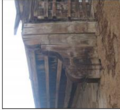
Şekil 13. Çıkmalarda kiriş işlevi gören ahşabın altına eklenen oymalı ahşap örneği-katalog no: 19
